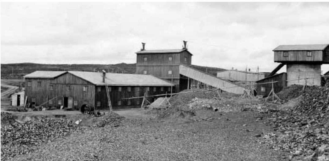
Flotasjonsanlegget like etter gjenoppbyggingen i 1946-47. Taubane-stasjon, silo og grovknuser til høyre, transportbånd til finknuser og sikteverk i midten og flotasjonshall. Foto: Rørosmuseets arkiv
